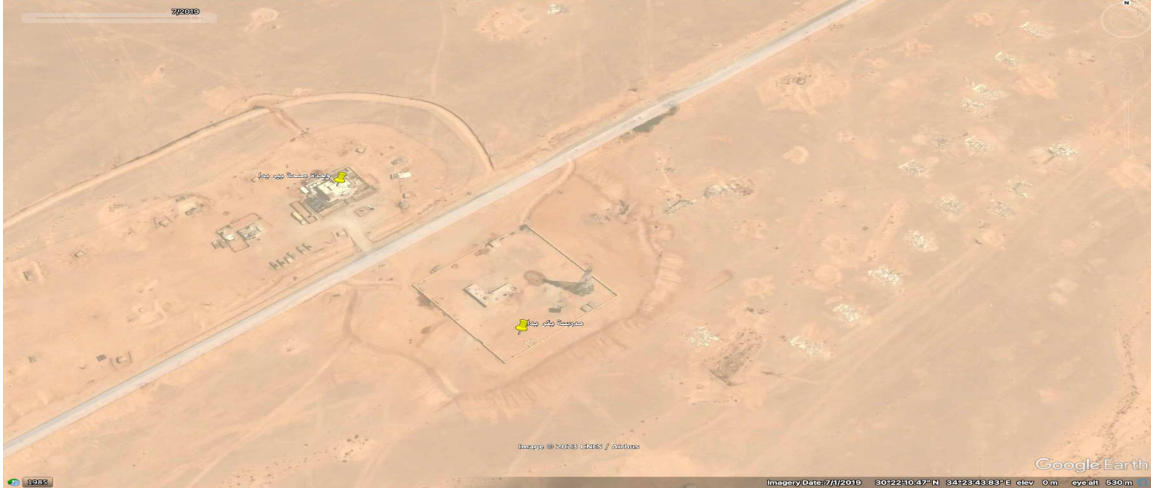
صورة 81: بتاريخ 7 يناير 2019 تظهر انشاء برج اتصالات لاسلكية داخل المدرسة وامتداد التحصينات الرملية لتشمل محيط المدرسة بشكل كامل. المصدر: جوجل إيرث برو.
