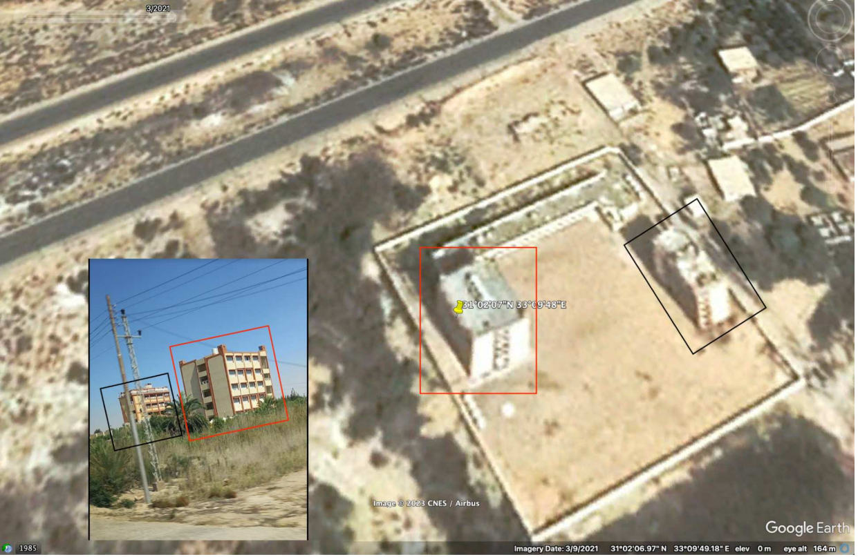
صورة 67: تظهر الصور الملتقطة بوضوح وجود ثلاث أبراج للمراقبة في المبنى الغربي بينما يظهر وجود تحصين بمساحة سطح المبنى الشرقي بالكامل.
